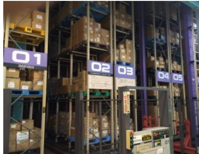
立体自動倉庫
